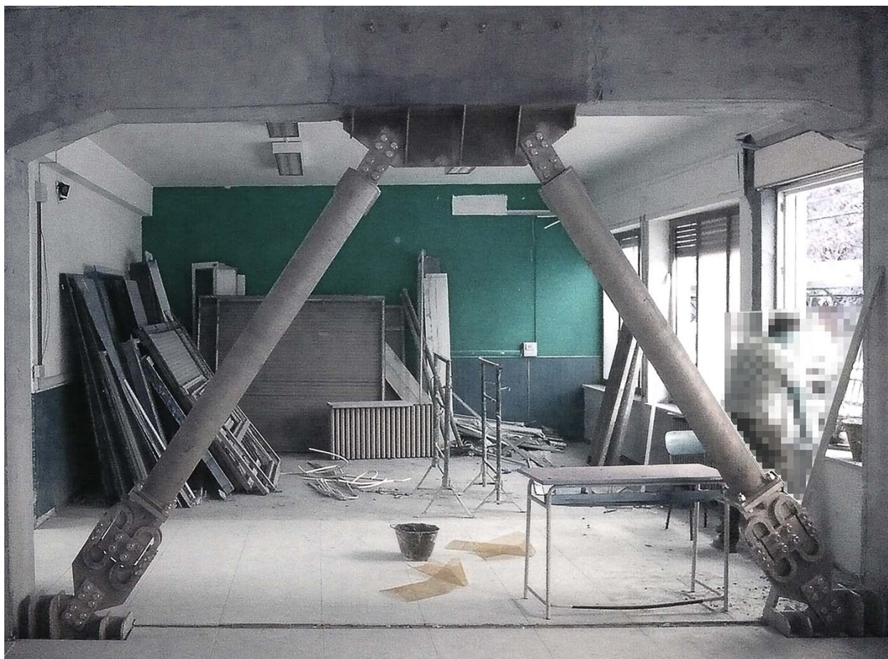
Installazione di controventi dissipativi
